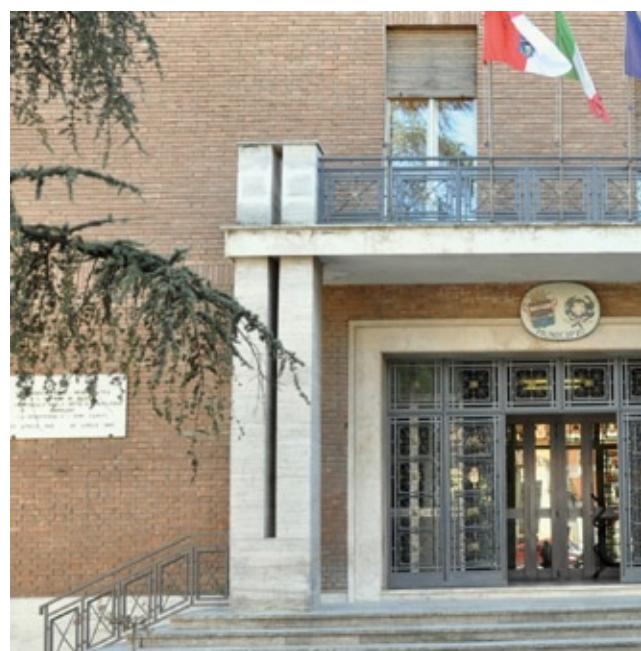
In alto il cancello prima dei lavori durante l'apertura degli uffici.
