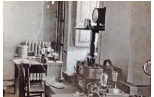
Nel laboratorio dell'Istituto, i contatori Geiger, che a Roma non esistevano, furono fabbricati personalmente da Fermi
