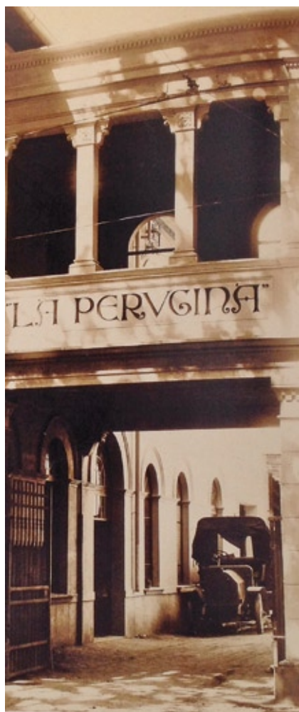
Veduta della facciata dello stabilimento Perugina di Fontivegge
