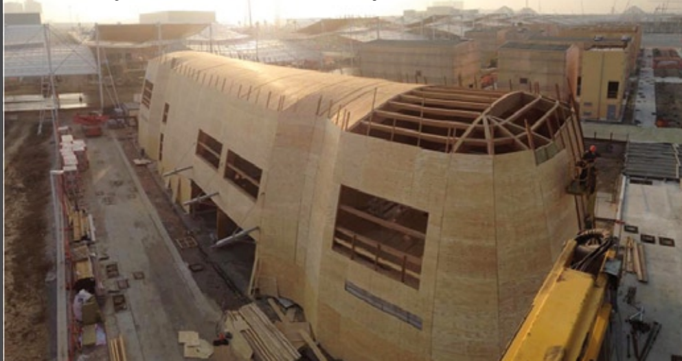
La struttura in legno lamellare del "Waterstone" in via di completamento
